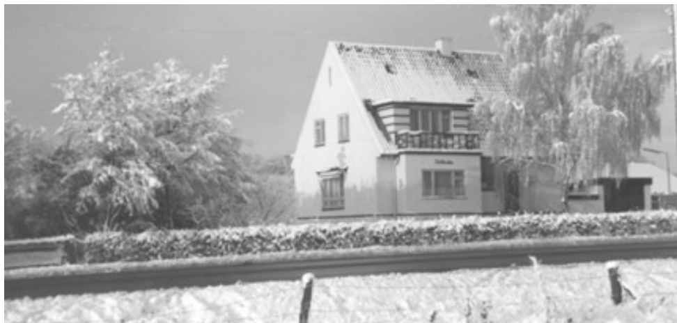
Slettensbo på Slettensvej 55, Søhus. Opført som gartneri i 1935 og nedrevet 1986
